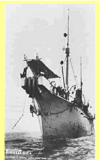
Figura 23 - La nave "Città di Milano" per la posa di cavi sottomarini (1890)
