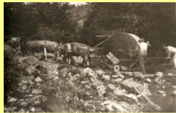
Figura 17 - Posa di cavi Pirelli in collina
